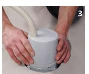
Das komplette Gehäuse mit eingebrachtem Installationrohr wird nun in die Aussparung bzw. Kernbohrung eingesetzt und...
