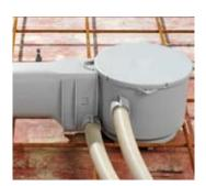
Die weiteren Montageschritte nach dem Betonieren sind je nach Frontteil unterschiedlich. Bei einigen Frontteilen bedarf es keinerlei weiterer Bearbeitung (siehe Seite 199). Andere Frontteile bieten die Möglichkeit der individuellen Einbauöffnungen, die entsprechend bearbeitet werden.
